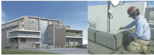
高齢者向け住宅の新築後、カラスによる糞害、ウレタンの食い散らかし被害(屋上冷却設備の冷却パイプ防護用発泡ウレタン)が発生しているため、施工会社よりご相談いただきました。対策として建物屋上の笠木と空調室外機へのバードコレンジャー塗布のご提案・実施。施工後は「一切カラスが寄り付かなくなつた」と、継続して利用いただいております。
